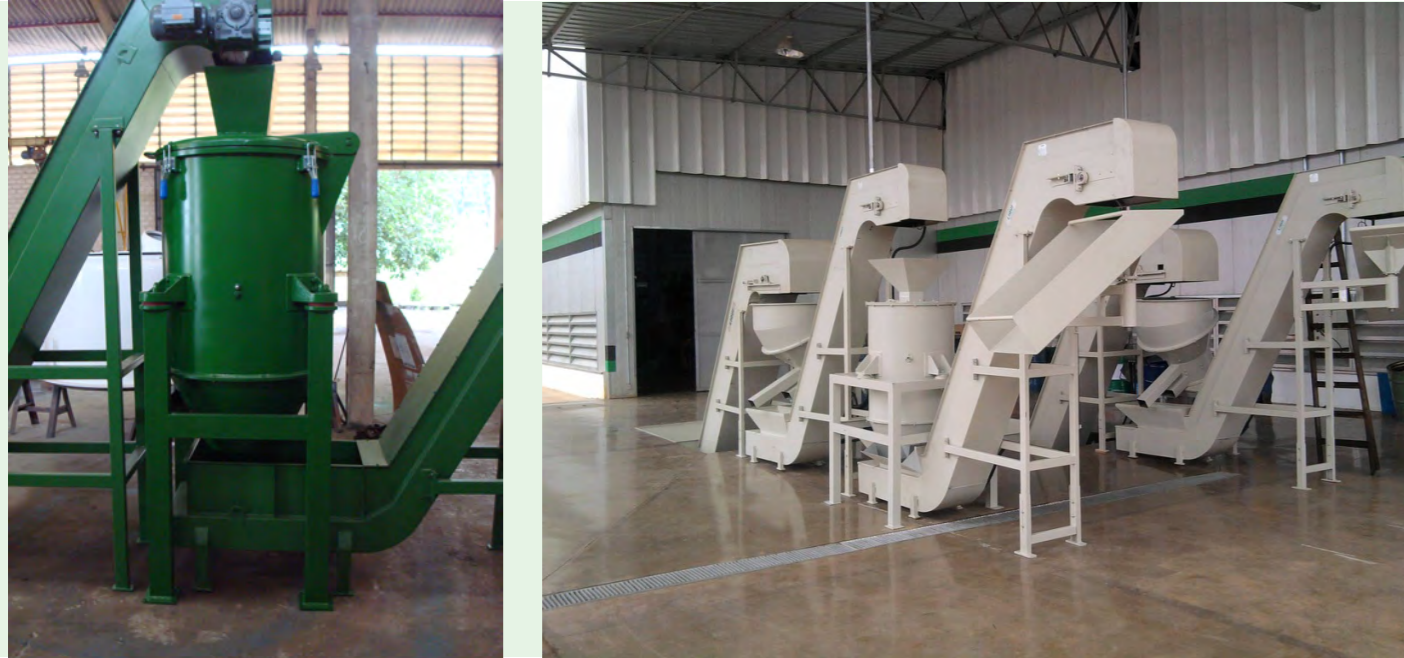
Sistema de Recuperação de óleo ▲
